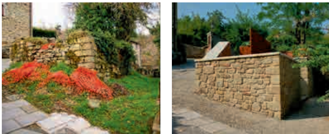
Fig. 14.7 – Riqualificazione di un'area degradata a seguito del crollo di un vecchio seccatoio ( a sinistra ), su progetto degli studenti del Dipartimento di Architettura dell'Università di Firenze. (Archivio Autore)
