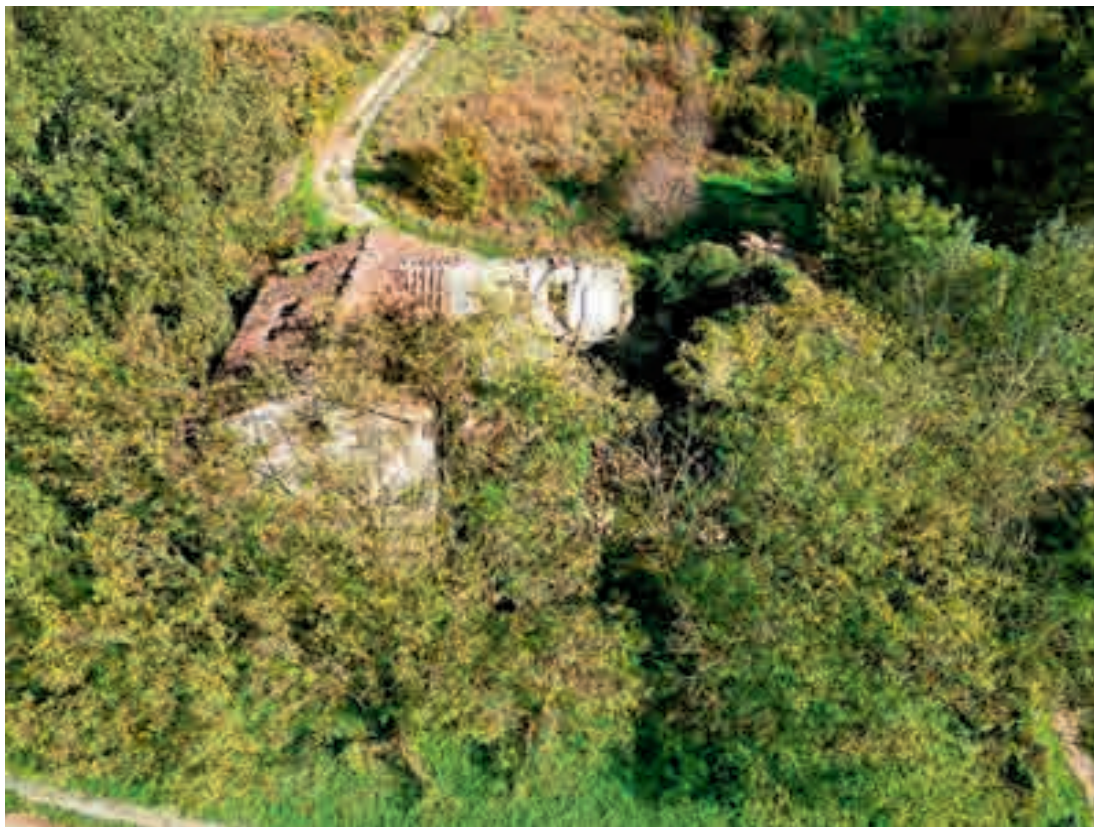
Fig. 19.8 – Chiesa di S. Clemente al Ponte, Pratovecchio-Stia. Stato di fatto a novembre 2024. (Foto di Giovanni Pancani)
