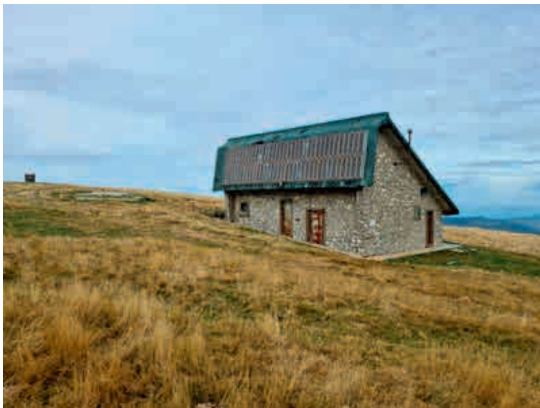
Fig. 21.4 – L'edificio in cima al Pratomagno, un tempo ex ripetitore della RAI, oggetto del progetto di riconversione funzionale. (Foto di Antonio Lauria).
