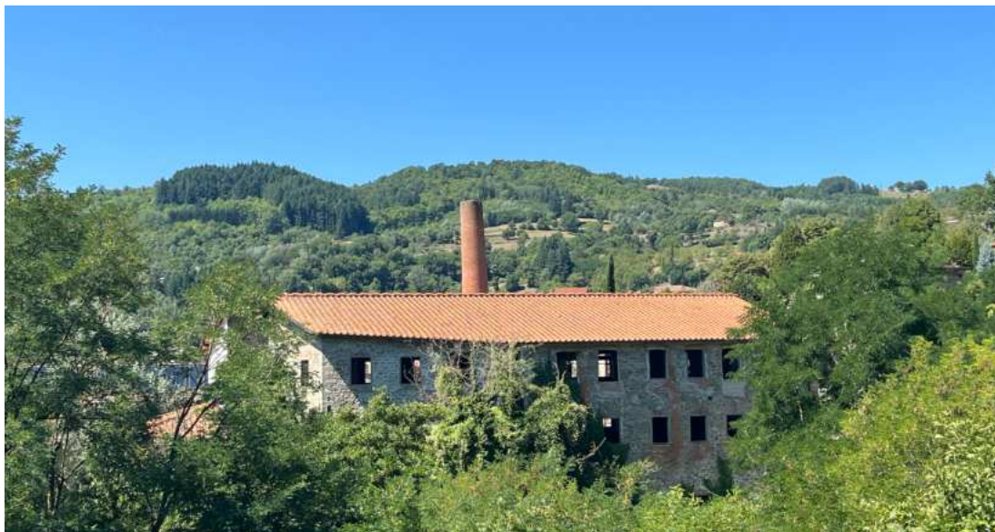
Veduta di una porzione dell'ex Lanificio di Stia, attualmente in disuso. (Foto di Maddalena Branchi)
