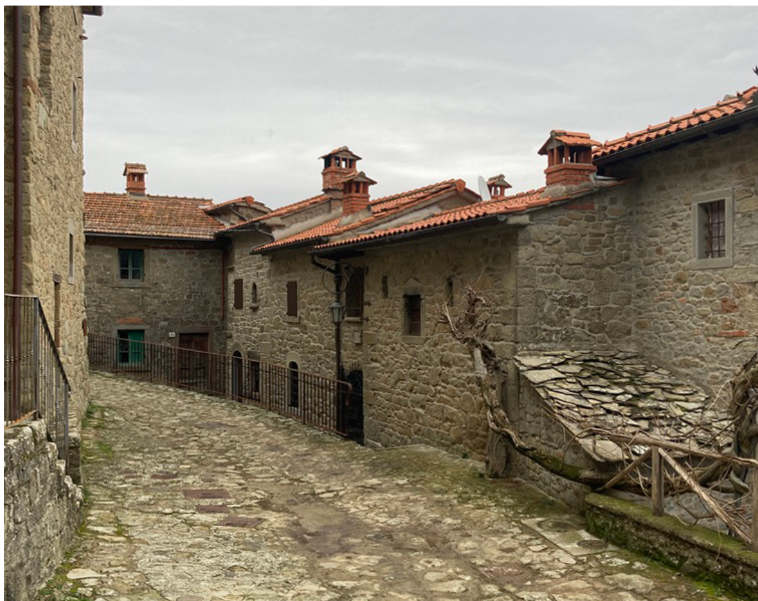
Veduta del borgo di Quota. In primo piano una piccola falda conserva ancora il tradizionale manto di copertura in pietra naturale, mentre gli edifici circostanti mostrano interventi più recenti con tegole in laterizio che segnano un netto cambiamento rispetto all’originaria tipologia costruttiva. (Foto di Eletta Naldi)
